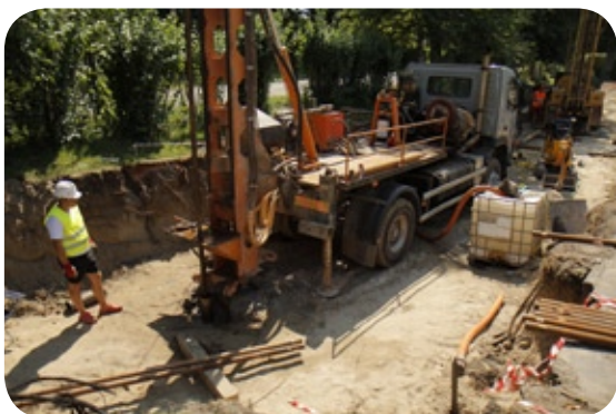
Vertikālo dziļurbumu ierīkošana bērnudārza teritorijā
