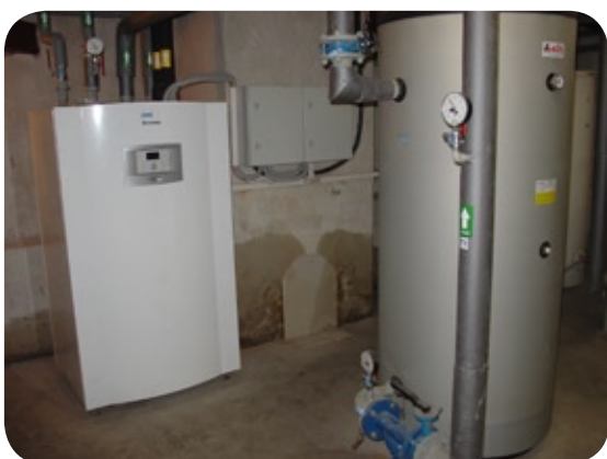
Divpakāpju siltumsūknis un akumulācijas tvertne
