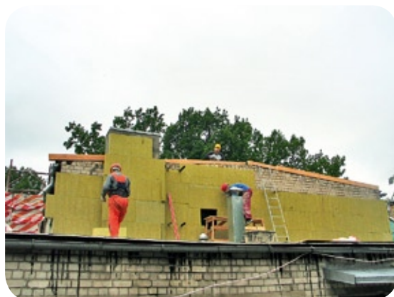
Ēkas ār sienas siltināšana ar akmensvati
