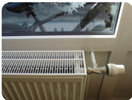
Katrs sildķermenis ēkā aprīkots ar termostātisko regulēšanas vārstu
