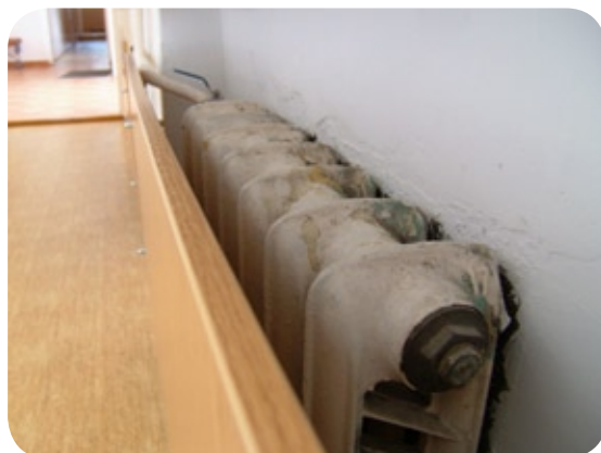
Vecā tipa čuguna radiatori pirms siltumapgādes sistēmas nomaiņas bērnodārzā
