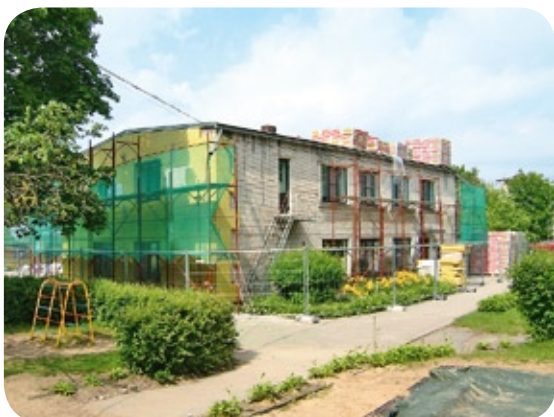
Uzsākot bērnudārza ēkas siltināšanu
