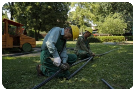
Termozondu sagatavošana ieguldīšanai dziļurbumos
