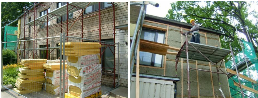
2. attēls. Bērnudārza ēkas sienu siltināšana ar akmens vati
