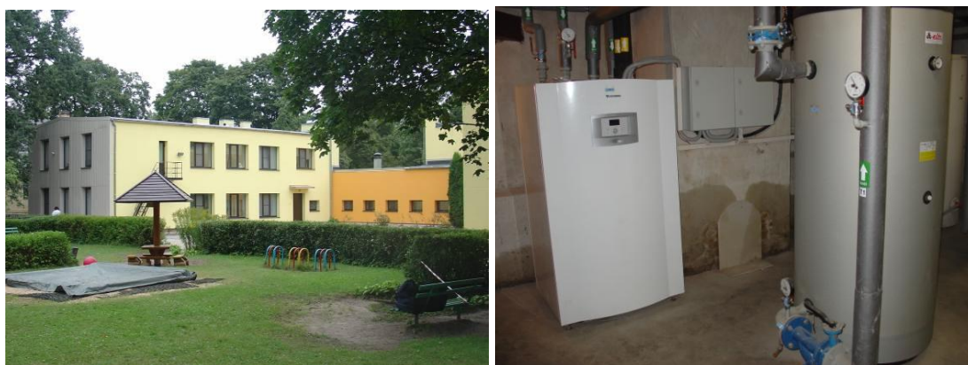
4. attēls. Siltumsūkņis ar dziļurbuma kolektoru bērnudārzā “Kastanītis” Rīgā.
