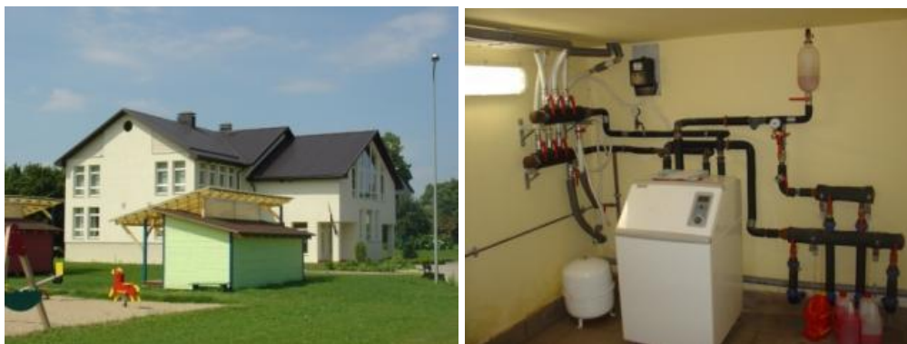
3. attēls. Siltumsūkņis un zemes horizontālais kolektors bērnudārzā “Ziedlejas” Smārdē.
