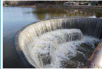
Demontavus užtvankos pralaidą, būtų atstatyta Salanto upės vaga ir įrengtas naujas tvenkinys.
